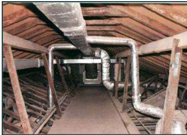
Postais 12 e 13 - Interiores (Sótão) - Curiosidades dos interiores do sótão, configurativos das formas como em 1700, e após, através dos cruzamentos de variadas traves de madeira, eram eficazmente suportados os telhados; e com que segurança ! (Os tubos são agora da reconstrução, respeitantes aos sistemas de águas e de ar condicionado).
